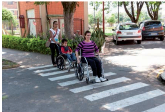
Figura 6 – Guia rebaixada de calçada
